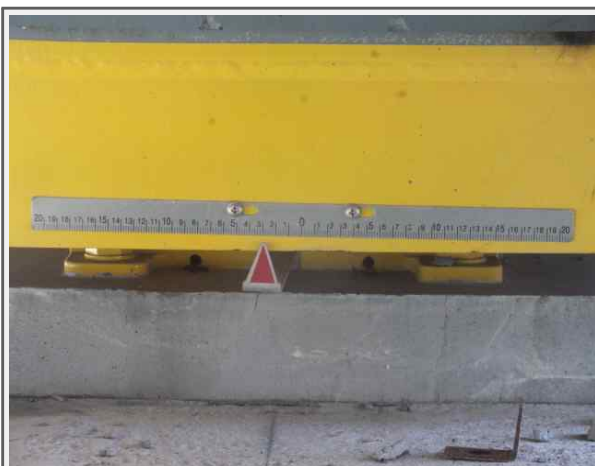
P7 교량반침 이동량 측정(상주)
