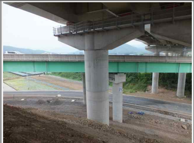
내 용 반정교(상주) 교각
