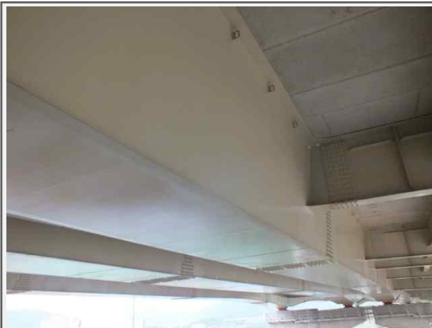
내 용 반정교(영천) 거더
