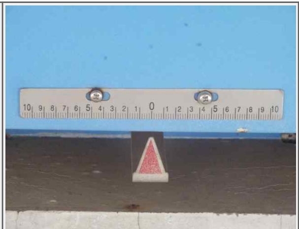
P4 교량반침 이동량 측정(영천)
