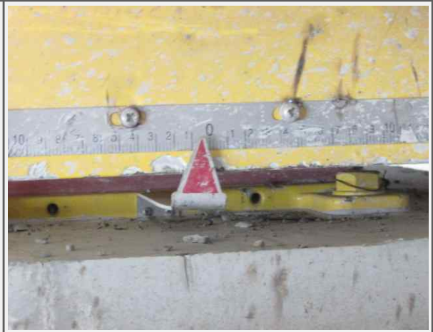
A1 교량반침 이동량 측정(영천)
