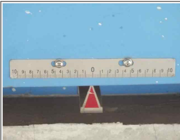
P4 교량반침 이동량 측정(상주)
