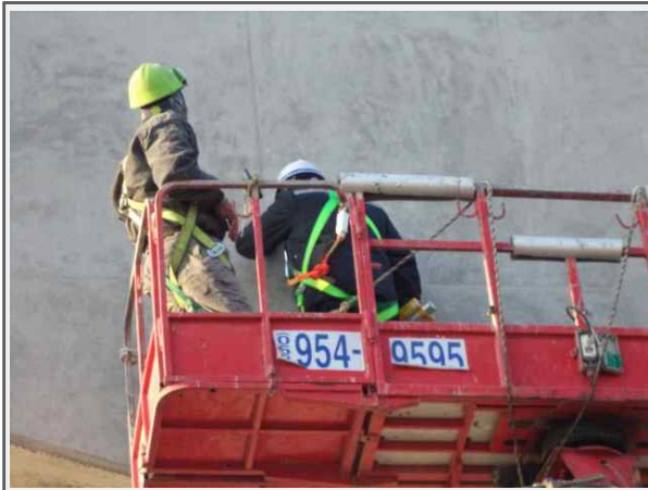
내 용 교각 코핑부 균열보수 현황
