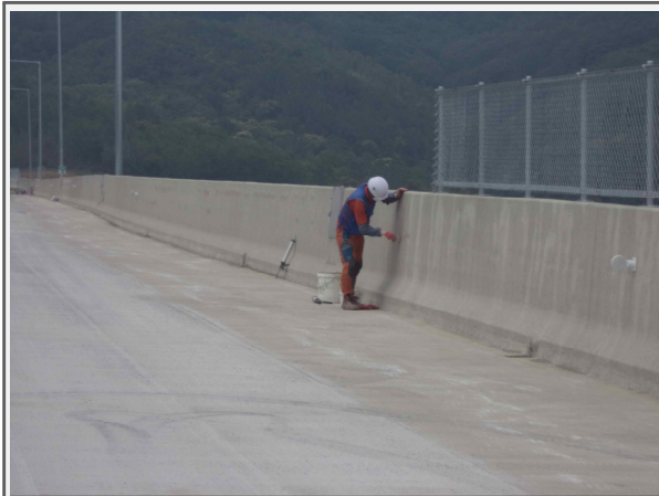
내 용 방호시설 균열보수 현황
