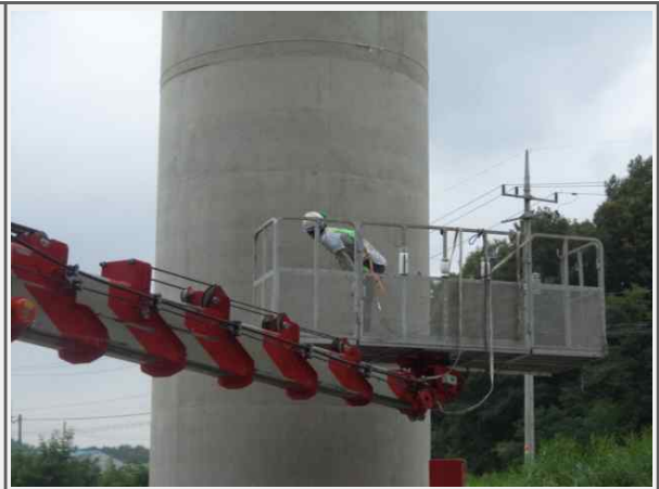
내 용 교각 기둥부 균열보수 현황
