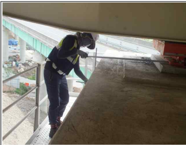
A1 연단거리 측정(상주)
