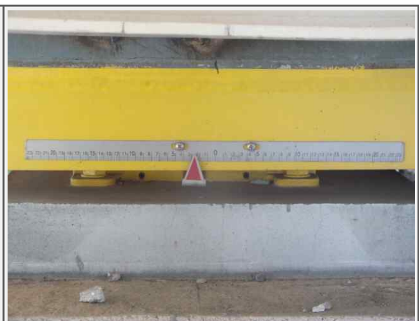
P7 교량반침 이동량 측정(영천)
