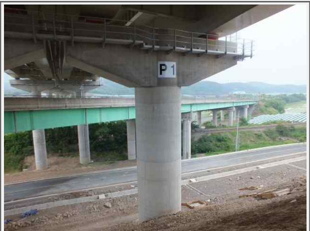
내 용 반정교(영천) 교각
