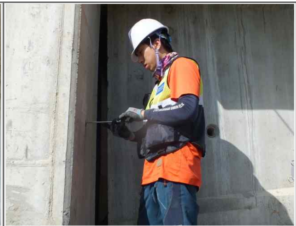
하부구조 탄산화깊이 측정
