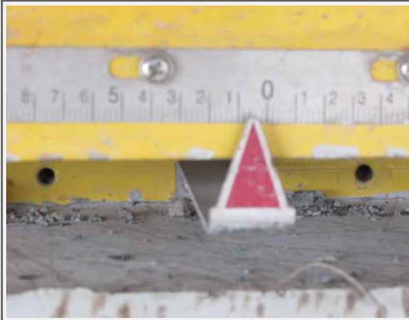
A1 교량반침 이동량 측정(상주)
